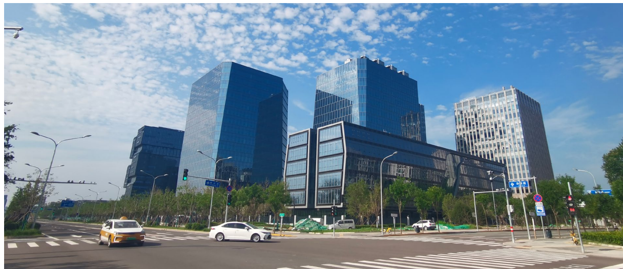
石景山代建项目实拍图
